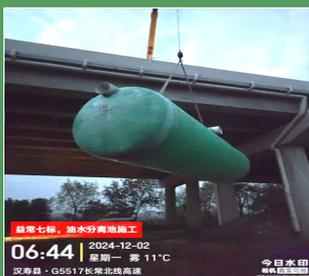
(1) 桥梁发生油车泄露、危化品泄露时，应先用吸油毡、围油设施、分散剂等处理，之后用水冲洗桥面，按3~5L/m<sup>2</sup>的水冲洗强度，管道收集冲洗水之后经**玻璃钢一体化油水分离池处理**，达标排放至自然水体。
