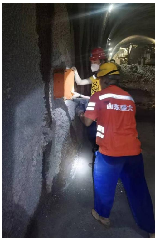
安全监测仪安装
