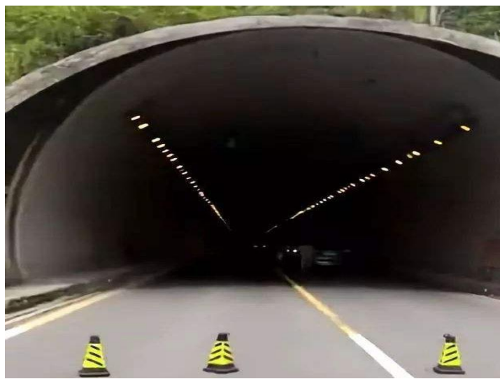
2019年湖北高速公路XX隧道
