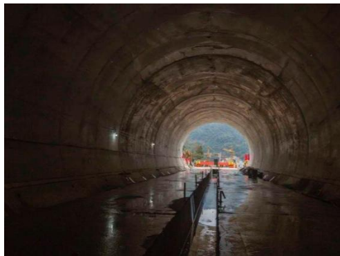
2021年杭衢铁路XX隧道
