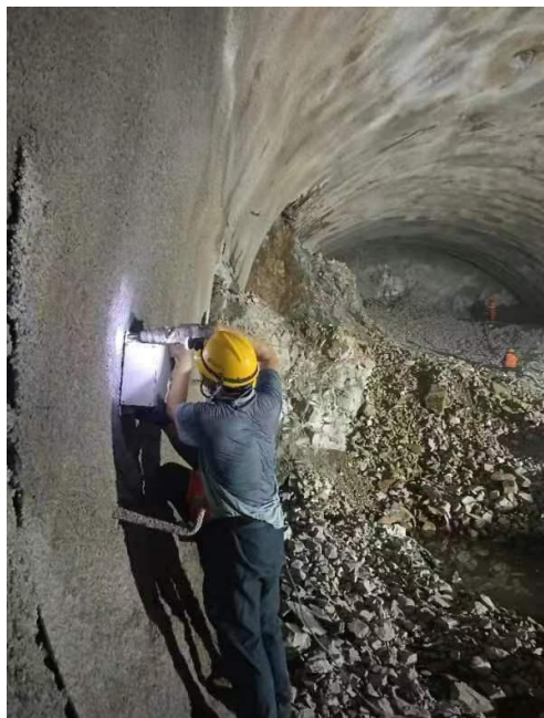
监测仪现场安装
